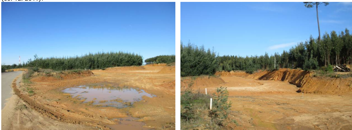
Fotografia 55 – Ponto 29: área de implantação prevista para a rotunda sul e a via rodoviária a norte desta (05/12/2019).
