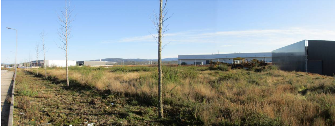
Fotografia 18 - Vista, a partir do ponto 9, da parcela 32 onde será instalado o equipamento social (05/12/2019).
