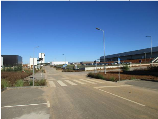
Fotografia 39 - Cruzamento de vias rodoviárias no ponto 22 (05/12/2019).
