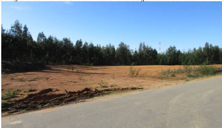
Fotografia 54 – Vista para norte da área prevista para a implantação da rotunda sul, a partir do ponto 29 (05/12/2019).
