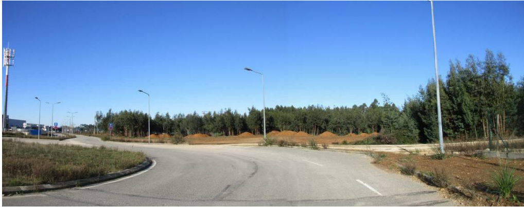
Fotografia 23 - Ponto 12: local onde será construída a via de acesso às parcelas 101 a 118 e área de implantação da parcela 113 (05/12/2019).
