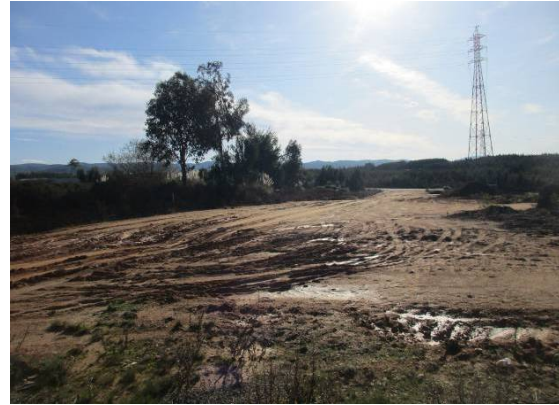
Fotografia 43 - Área prevista para a implantação da via rodoviária a sudoeste das parcelas 72 a 77, no ponto 23 (05/12/2019)
