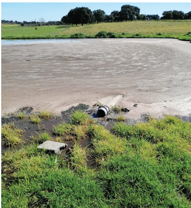
Lagoa e tanque de retenção sem folga de segurança
