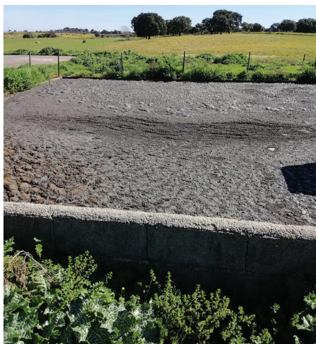
Lagoa e tanque de retenção sem folga de segurança
