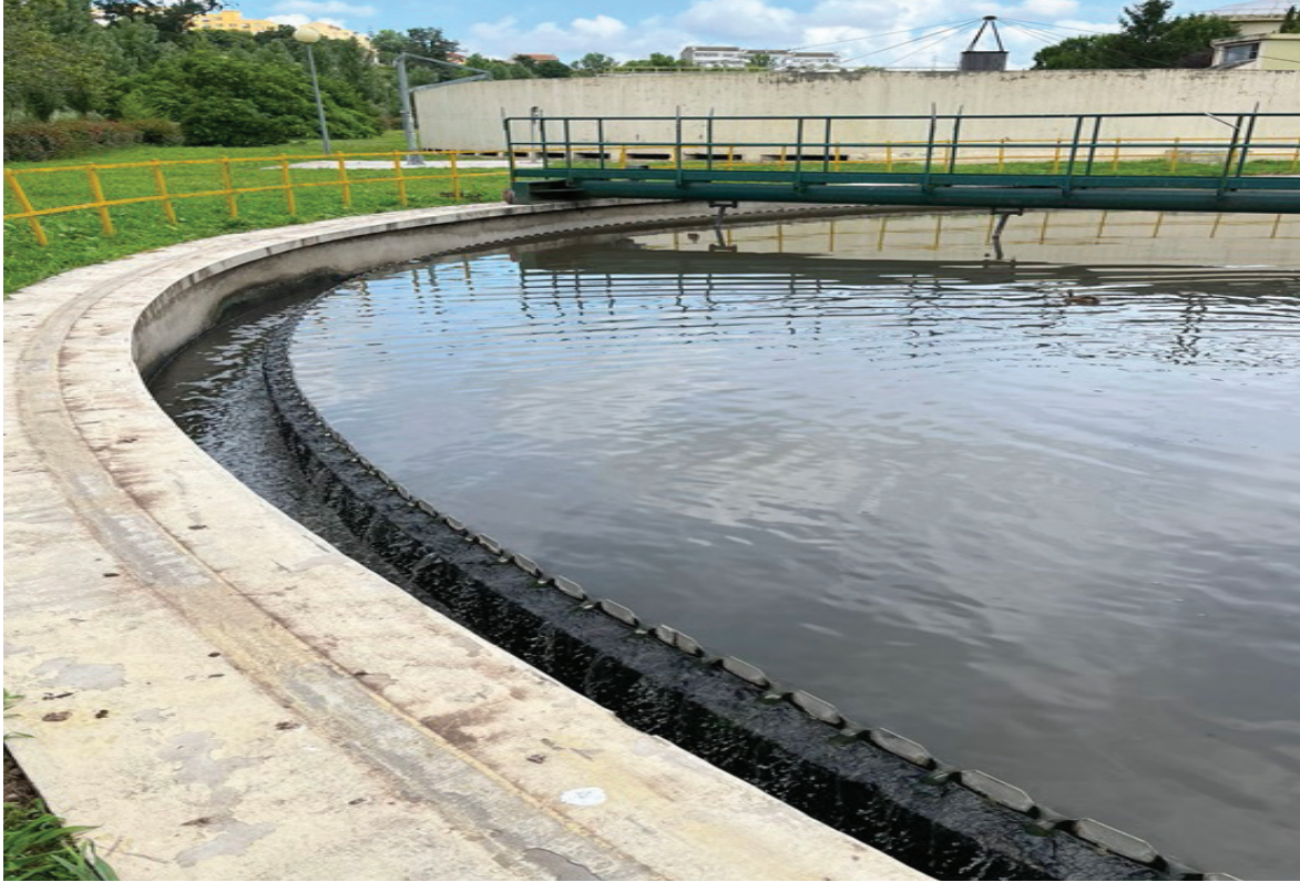
Fiscalização a ETAR Urbana e respetiva amostragem de efluentes
